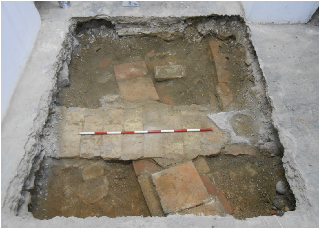
Fig. 1.-Estat del sondeig al moment d'arribar l'arqueòleg (des del Nord).
