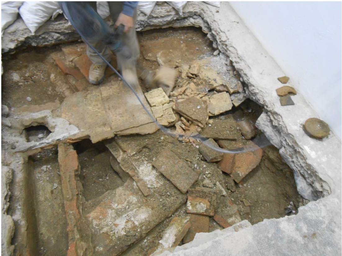
Fig. 3.- Desmuntatge de les estructures de canalització d'aigua (des de l'Oest)
